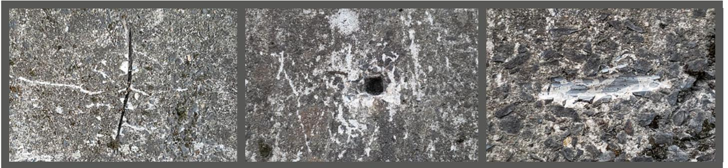
Der Kletterbunker besteht aus Beton mit einem relativ hohen Anteil an Stahl bzw. Stahl-Armierung. Die Oberfläche, an denen die Risse und Löcher liegen, besteht überwiegend aus Beton mit vereinzelt Tonsegmenten. Der Beton hat spröde Eigenschaften und kann unter Druck (bei Verwendung von Eisgeräten beim Drytoolen) an der Oberfläche an den Kanten brechen.
